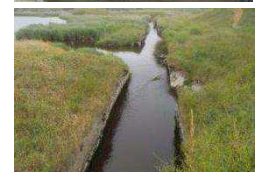
Ouvrage sous la D152 et canal d'entrée au niveau du Petit Loc'h
